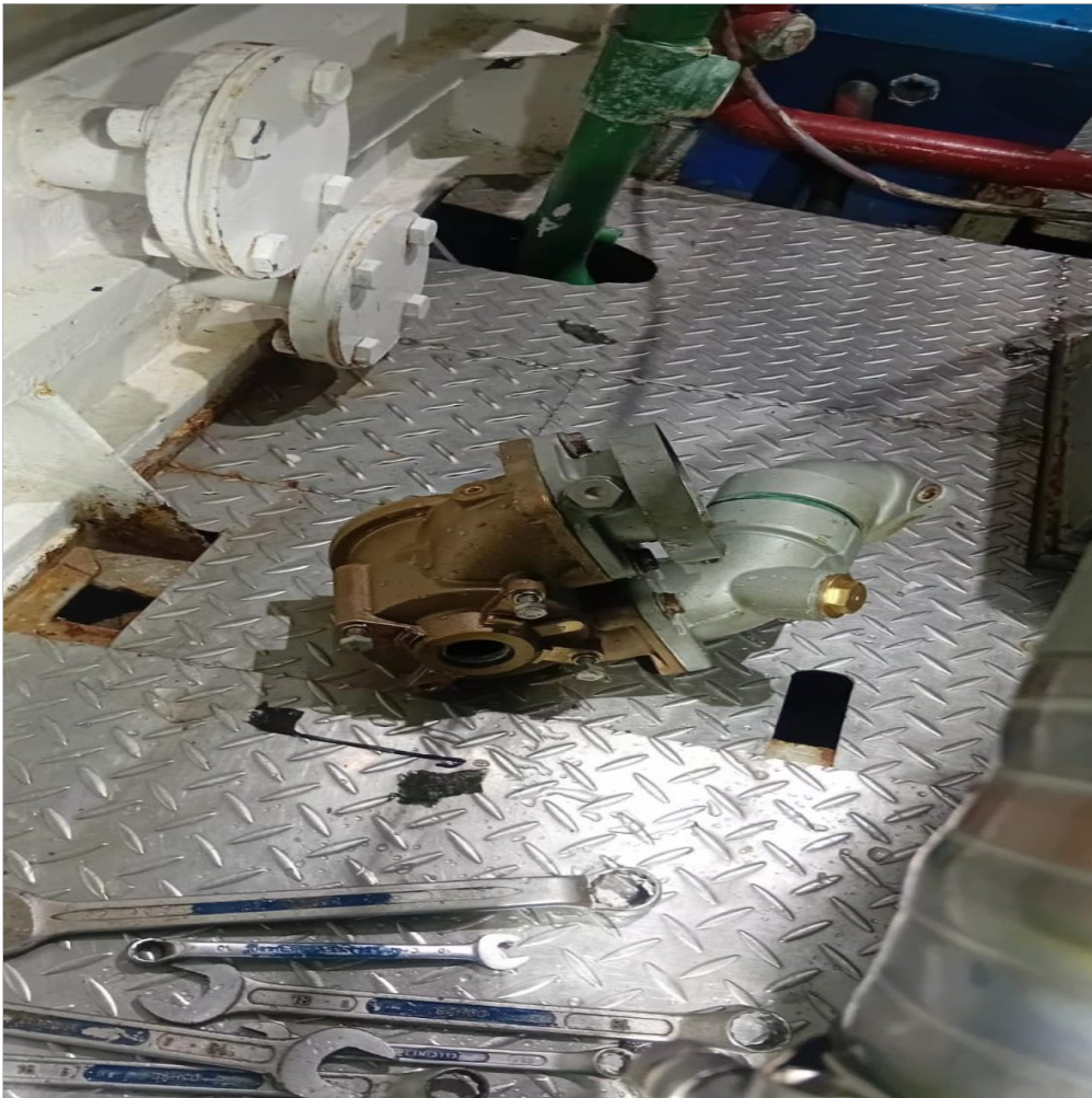
revisión bomba agua de mar
