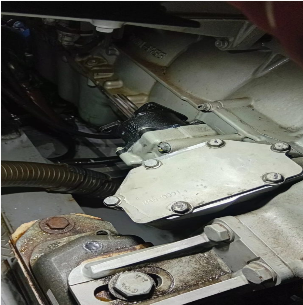
revisión en mando de bomba de agua
