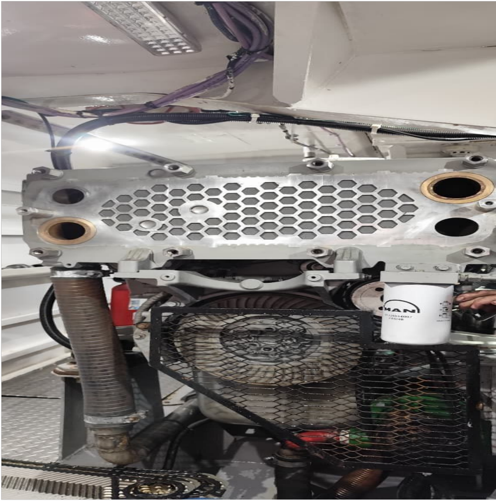
limpieza tanque compensador
