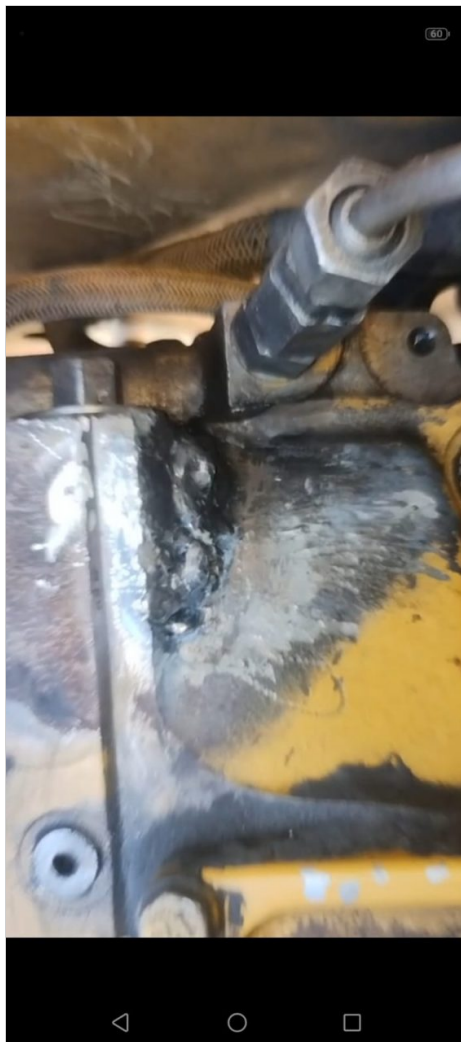
despues de reparar
