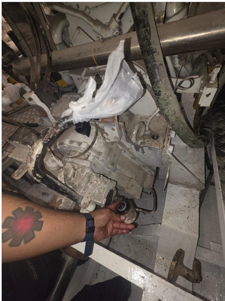
Extraccion y limpieza de filtro magnetico de transmision
