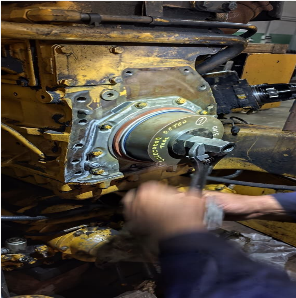
instalador de reten bancada trasero
