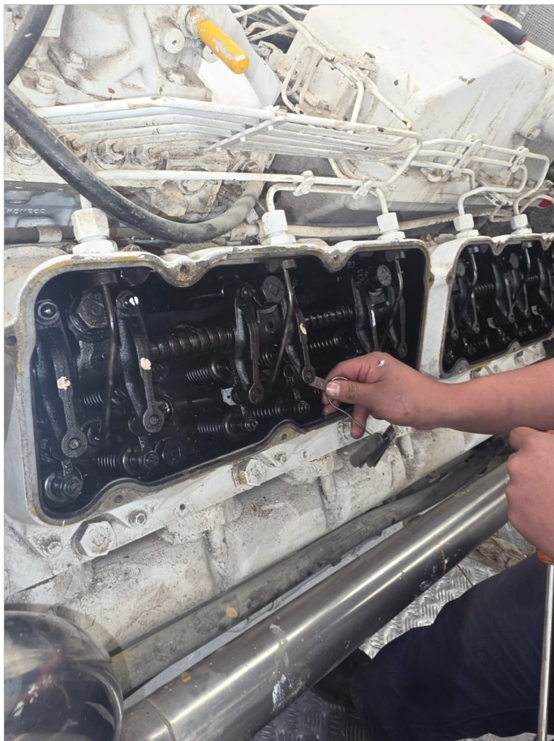
Regulacion de valvulas
