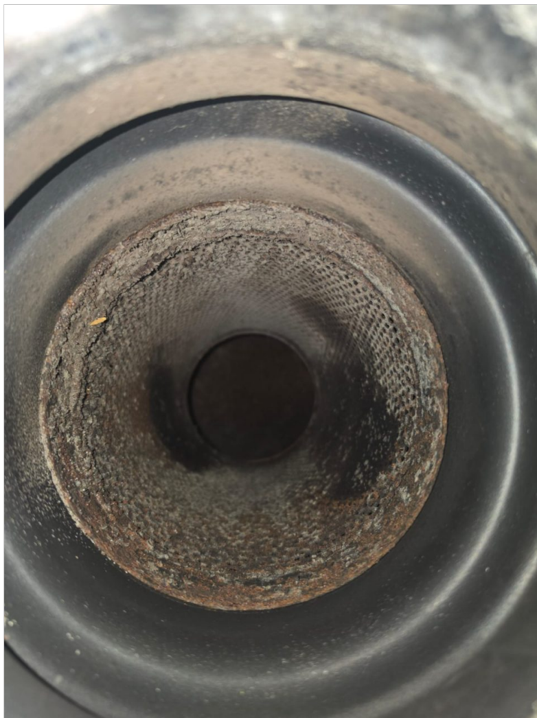
Filtros de aire en mal estado,
