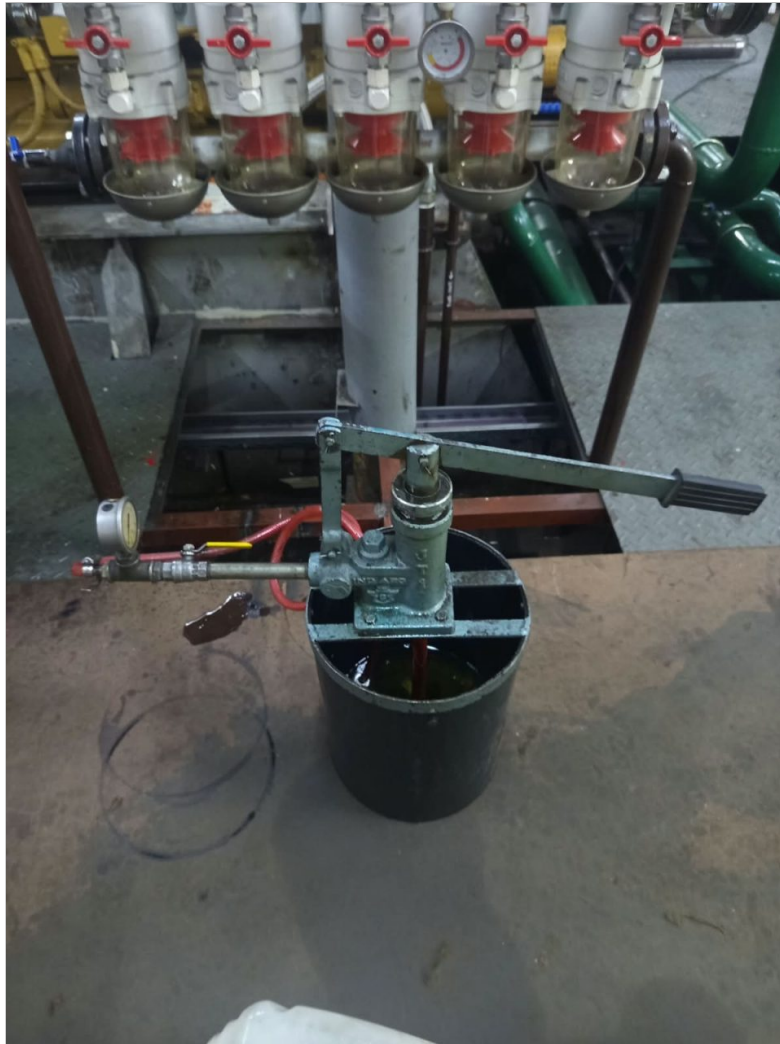
Bomba manual utilizada para la prueba.
