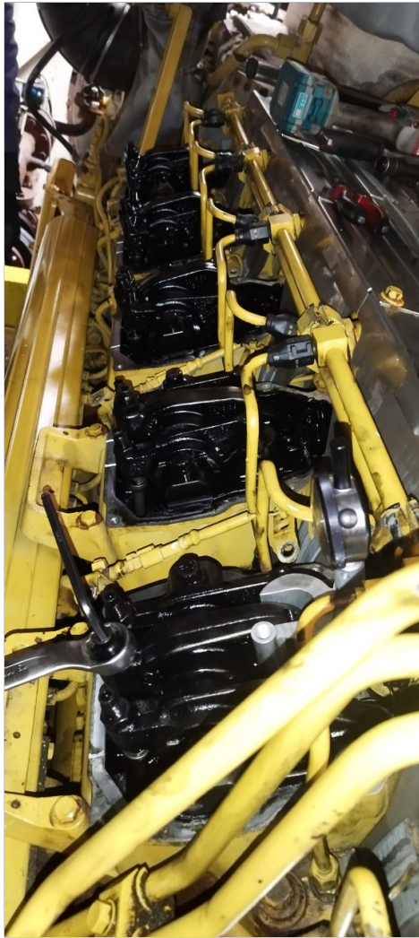
Desmontaje de tapas de calvulas
