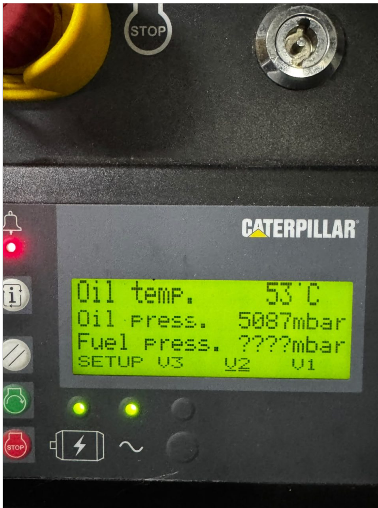
Presión de combustible
