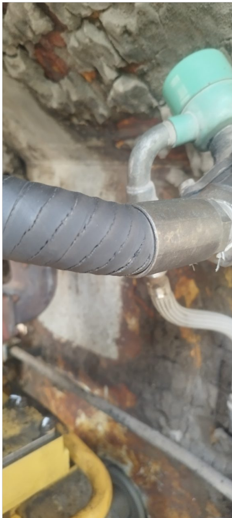
Manguera a reemplazar
