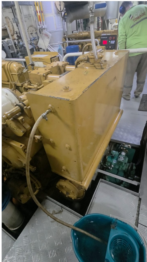
Prueba de aire o gases de escape en circuito de refrigeracion
