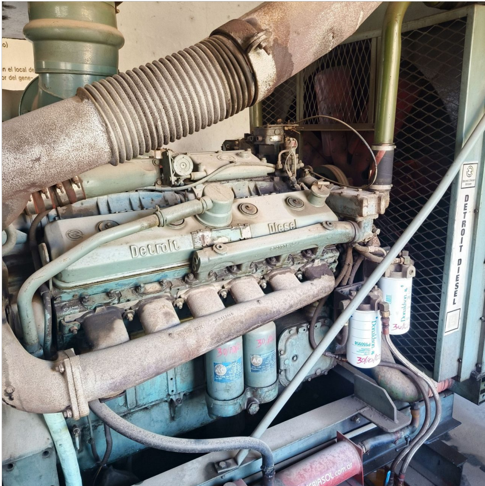
Revision circuitos lado filtros
