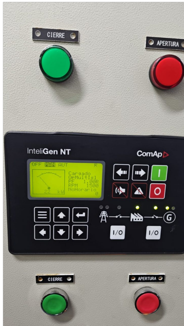
Grupo en barra funcionando correctamente
