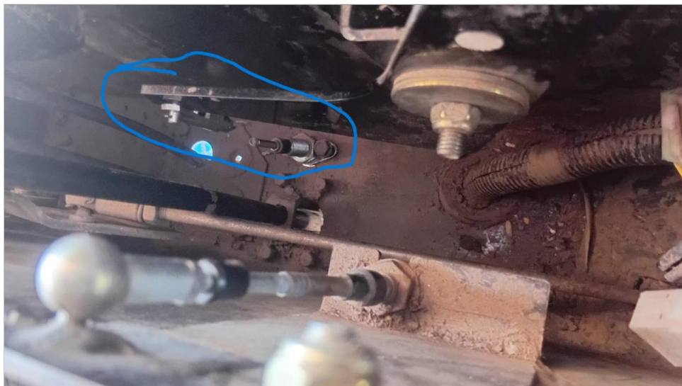
Cable TDF roto.
