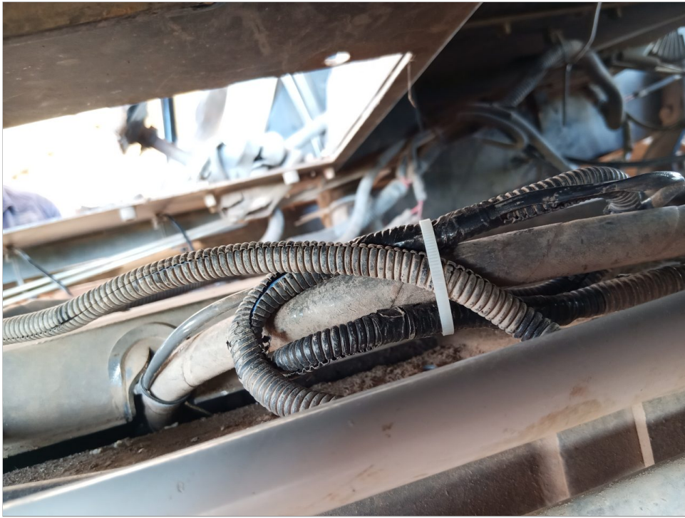
Arnes electrico del solenoide de par multiple reparado
