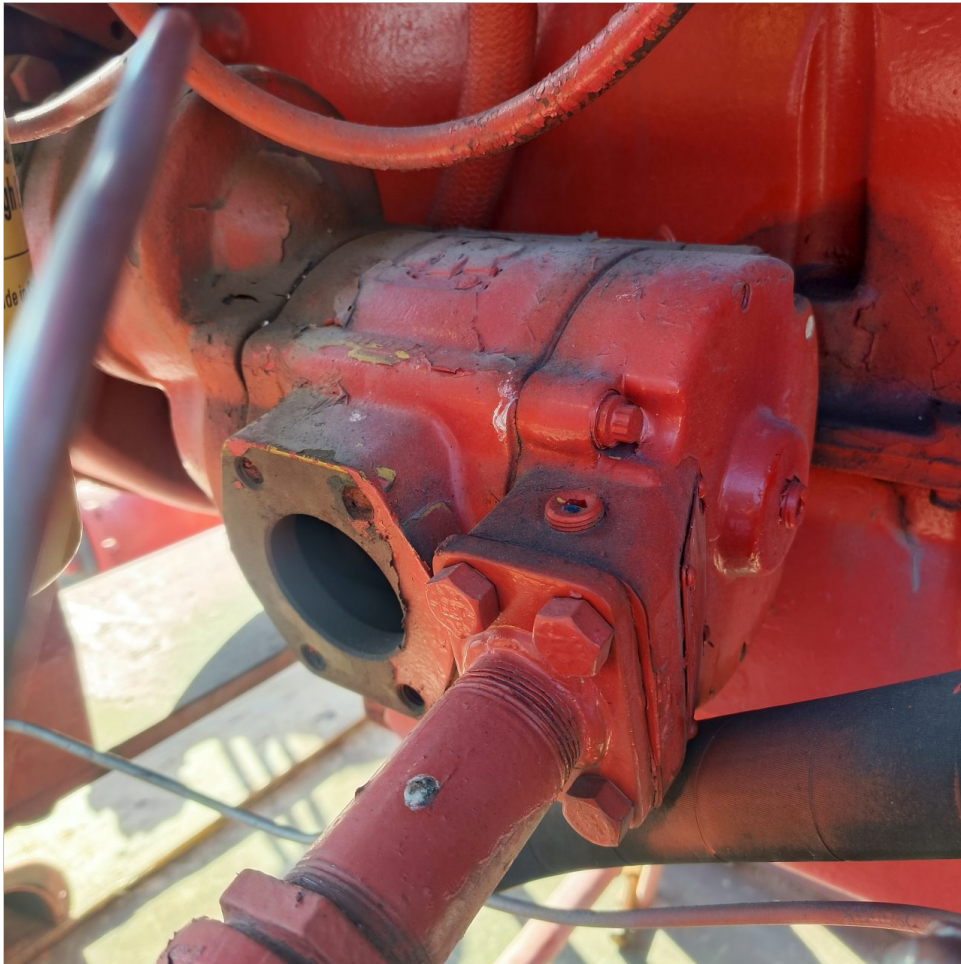
Observacion de Silenciador en arranque neumatico (faltante)
