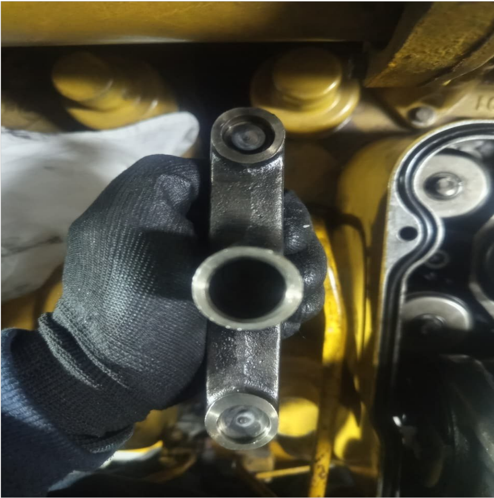
Se controla la integridad de los balancines, botadores, tren de válvulas, etc.
