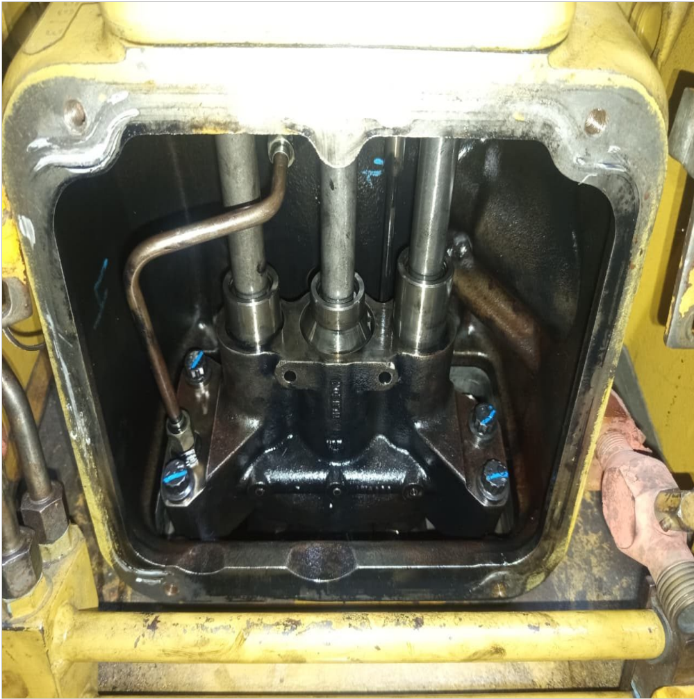
Instalación de botadores y líneas de lubricación.
