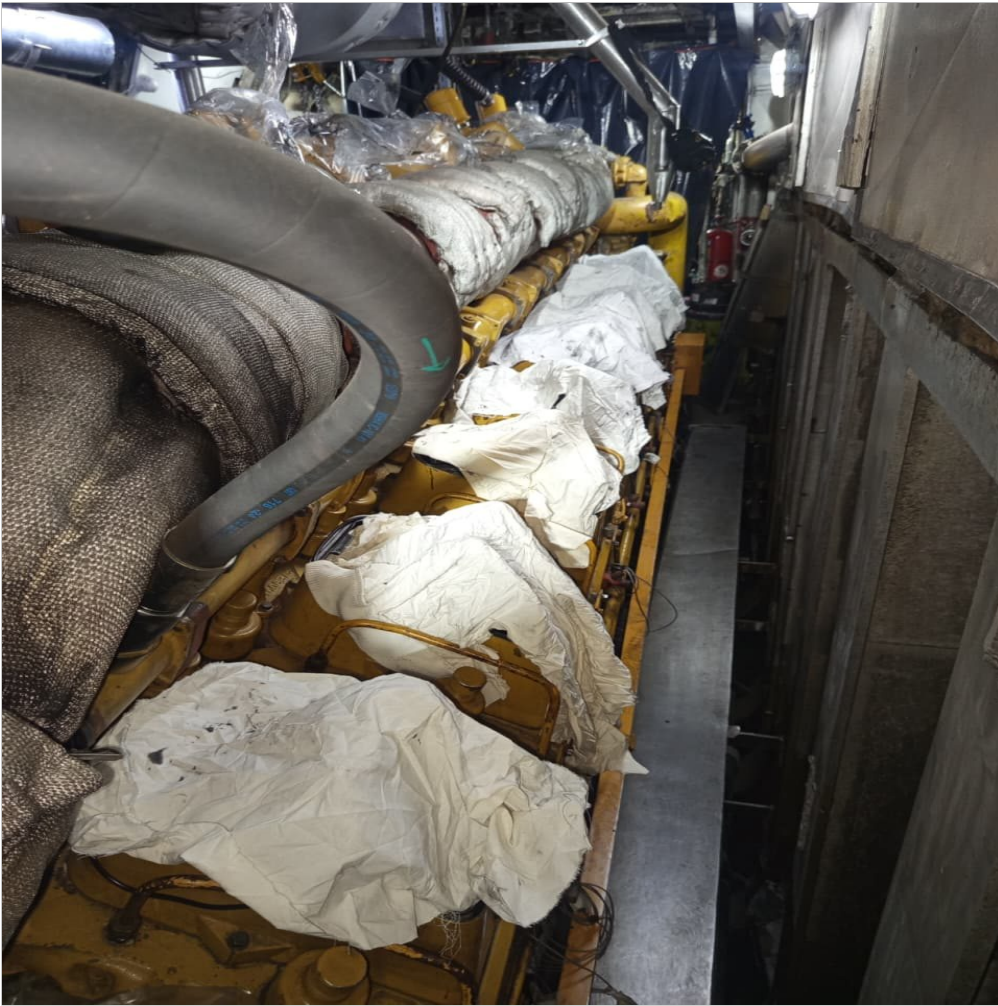
Se retiran botadores y varillas para facilitar la operación
