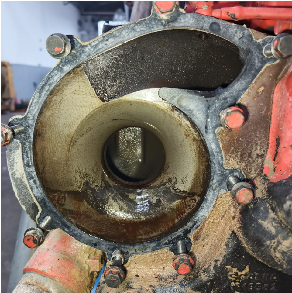
Bomba de agua - desmontaje 1
