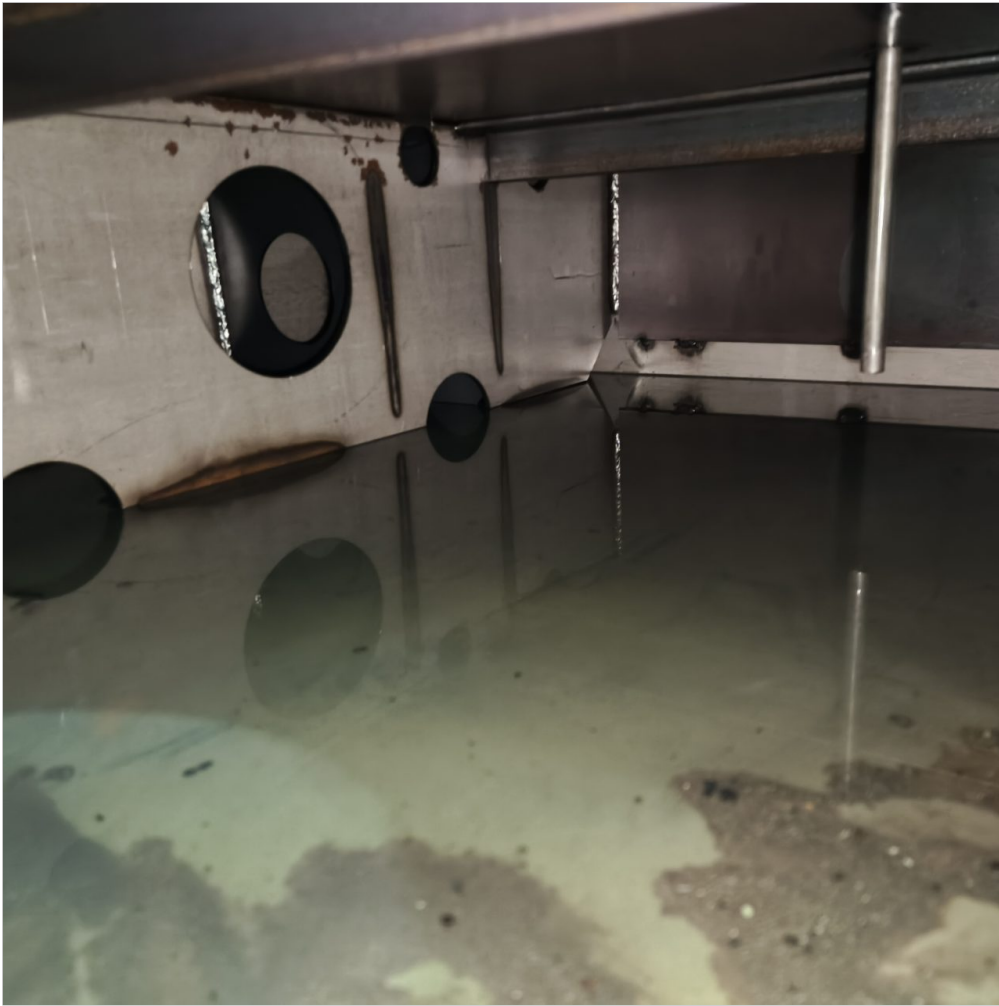
Tanque combustible - inspeccion estado interior operativo
