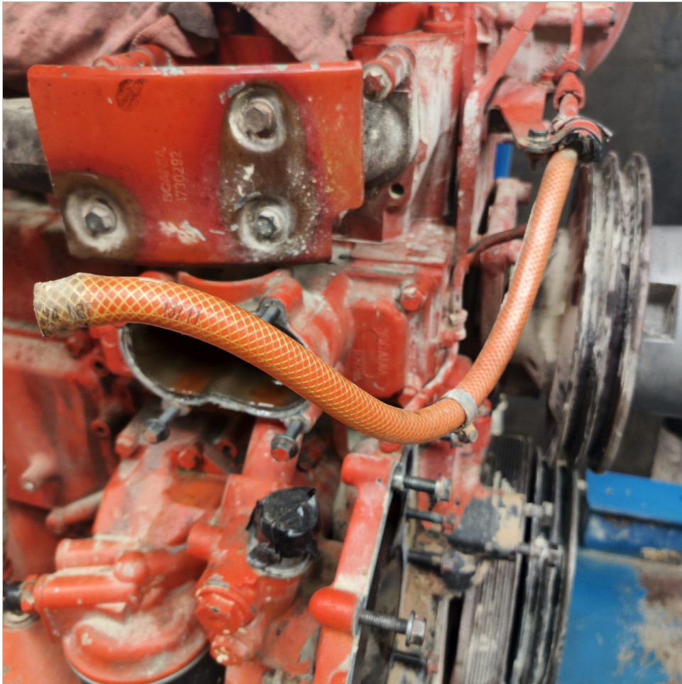
Mangueras y caños 1
