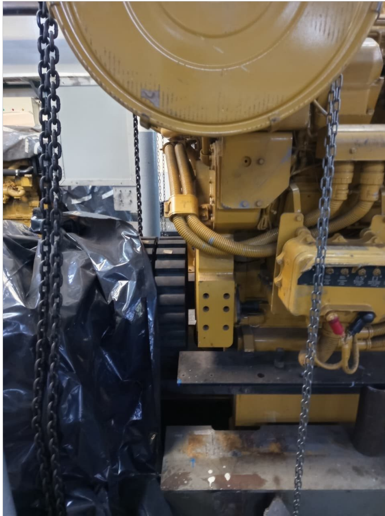
Motor Principal Cat 3516 Babor. - Maniobra de izaje para adaptacion de basamento.
