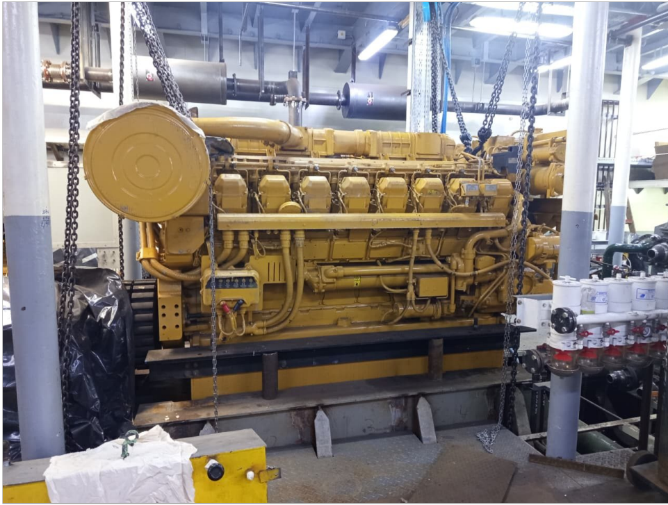
Motor Principal Cat 3516 Babor. - Maniobra de izaje para adaptacion de basamento.
