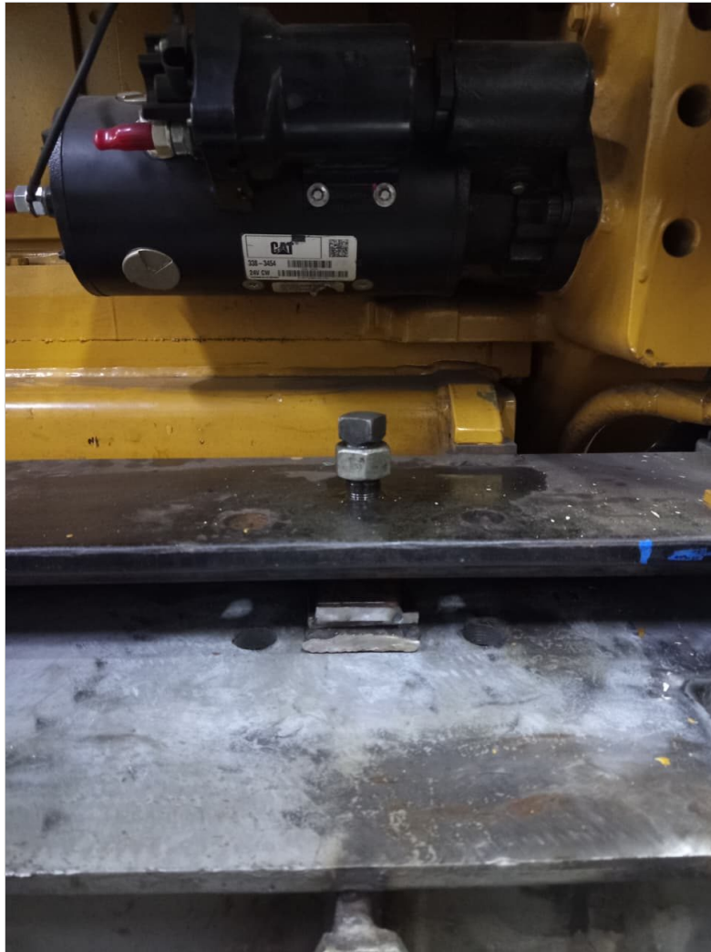
Motor Principal Cat 3516 Estribor. - Perforación del basamento.
