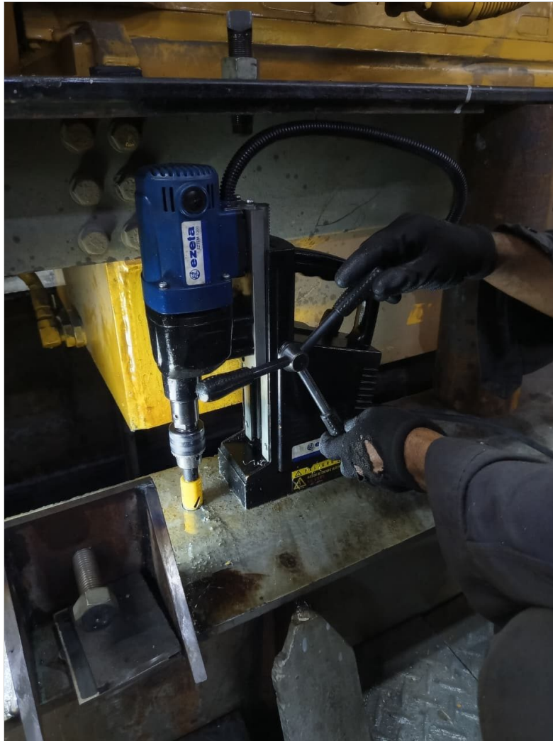
Motor Principal Cat 3516 Estribor. - Perforación del basamento.
