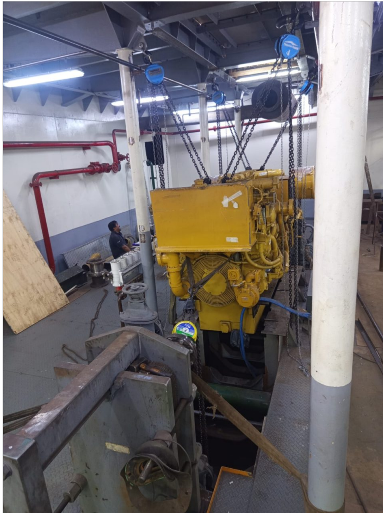
Motor Principal Cat 3516 Estribor. - Maniobra de izaje para adaptación de basamento.
