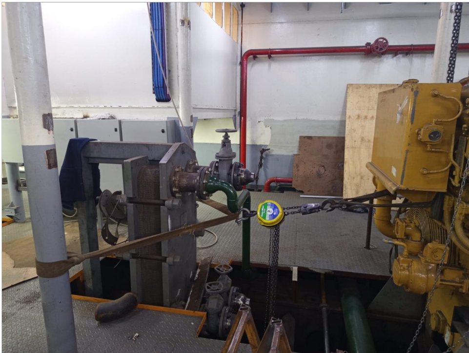
Motor Principal Cat 3516 Estribor. - Maniobra de izaje para adaptación de basamento.
