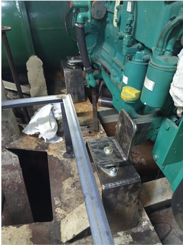
Instalación de patas de apoyo y anti-vibratorios.
