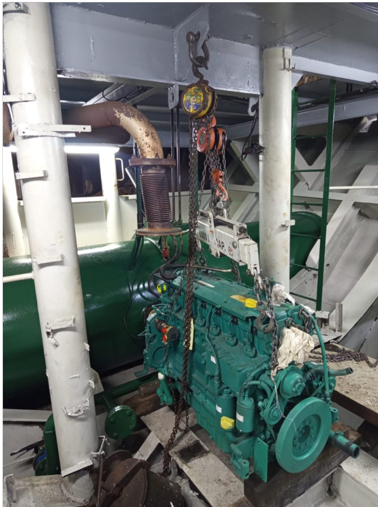
Maniobra de Instalación y alineacion.
