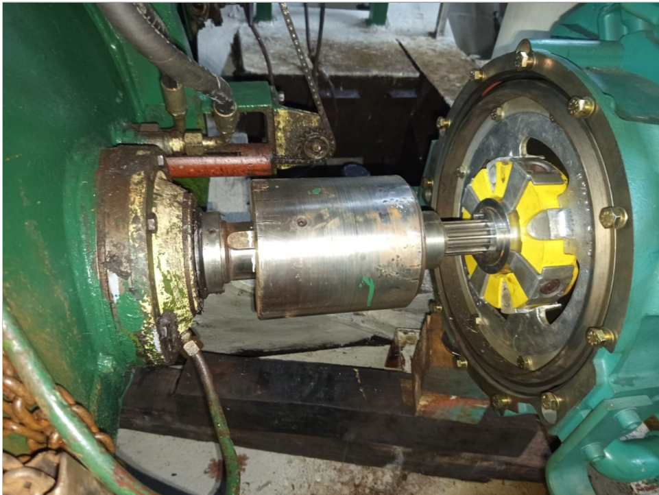
Maniobra de Instalación y alineacion.
