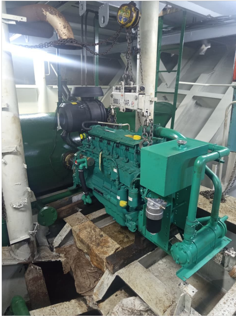
Acondicionamiento del equipo.
