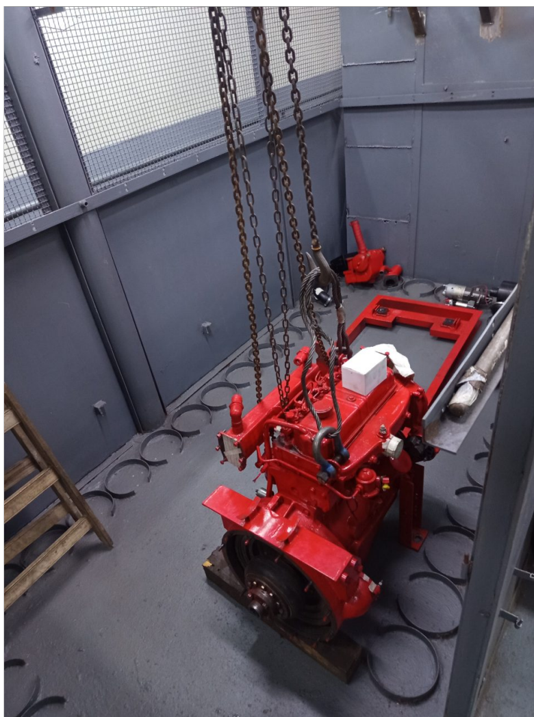
Moto-Bomba (Perkins 4-203) - Maniobra de Instalación y alineación.
